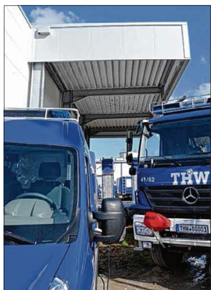
Neu am THW-Gebäude ist der Carport für den Tieflader.
